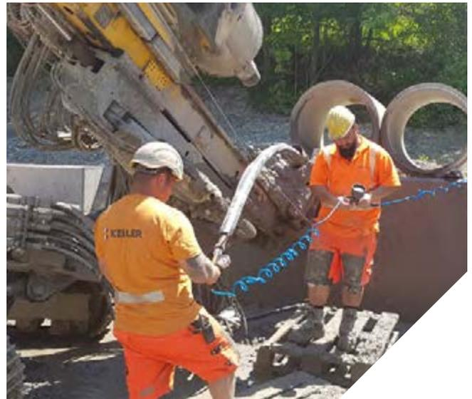
**DICHTIGKEITSTEST DES EINGEBAUTEN**
