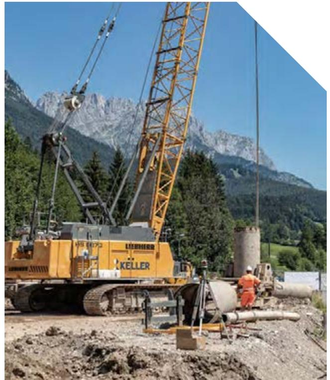
Aufgrund der beengten Platzverhältnisse, der variierenden Bodenverhältnisse von steinig, blockig, kiesig, sandig und dem anstehenden Grundwasser wird eine aufgelöste Bohrpfehlwand DN120 mit DSV Zwickel-Ausfachung hergestellt.
