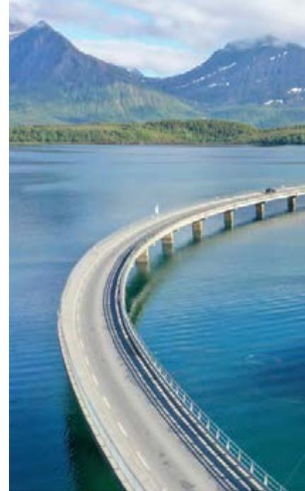
Für die neue Brücke zwischen der Insel Engeløya und Bogen führt Keller Geoteknikk alle geotechnischen Arbeiten für die Gründung aus 84 Pfählen mit einer Länge von rund 2.000 m, abgeteuft im Reverse-Circulation-Bohrverfahren, sind herzustellen. Keller hat vor Beginn der Arbeiten auch Boden- und Felsuntersuchungen durchgeführt, um das Niveau und die Qualität des in der Planungsphase angenommenen Untergrunds zu überprüfen.
