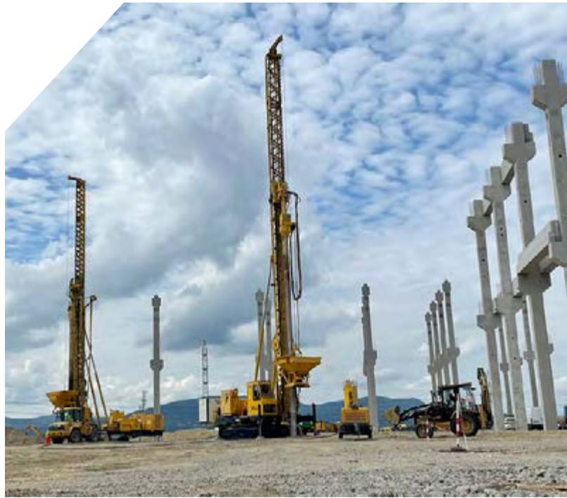
Insgesamt haben wir für die Gründungsarbeiten Bohrungen von ca. 84.000 m für SOB-Pfähle mit Durchmessern zwischen 400 und 1.000 cm ausgeführt. Darüber hinaus haben wir mehr als 27.000 m Rüttelstopfverdichtung und mehr als 5.500 m Soilcrete®-Säulen zur Bodenverbesserung ausgeführt.
